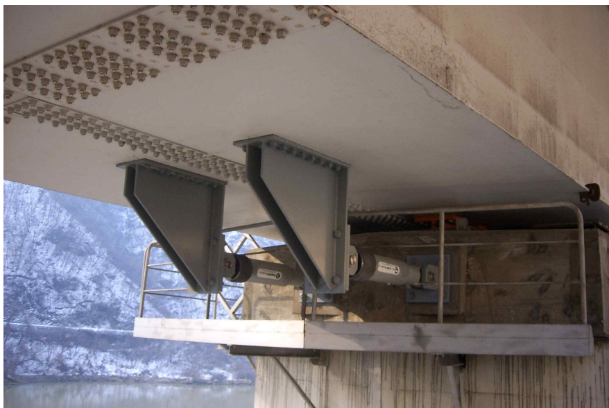
그림. B.2.7 교각부 댐퍼 설치 예
